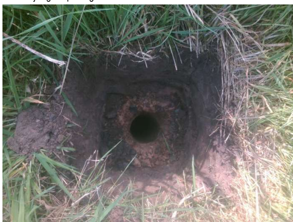
Fotonummer: 3 Omschrijving: Inspectiegat B001
