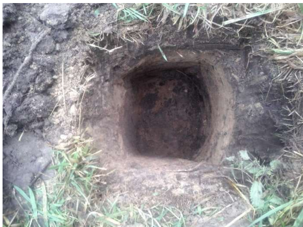
Fotonummer: 1 Omschrijving: Inspectiegat A316
