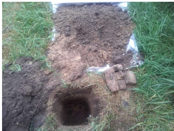
Fotonummer: 2 Omschrijving: Inspectiegat A316
