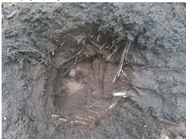
Fotonummer: 17 Omschrijving: Inspectiegat C008
