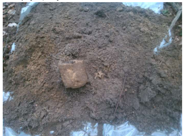
Fotonummer: 18 Omschrijving: Inspectiegat C008
