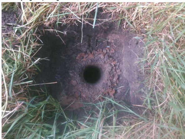
Fotonummer: 5 Omschrijving: Inspectiegat B002
