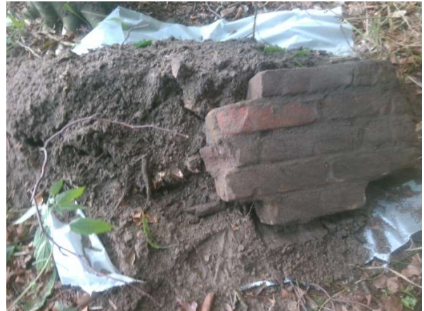
Fotonummer: 14 Omschrijving: Inspectiegat C006
