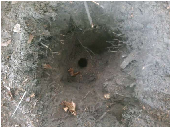
Fotonummer: 25 Omschrijving: Inspectiegat C017
